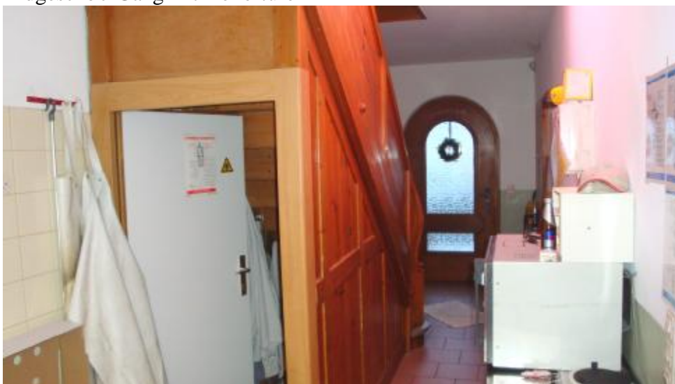
Erdgeschoß-Gang mit Kellertüre
