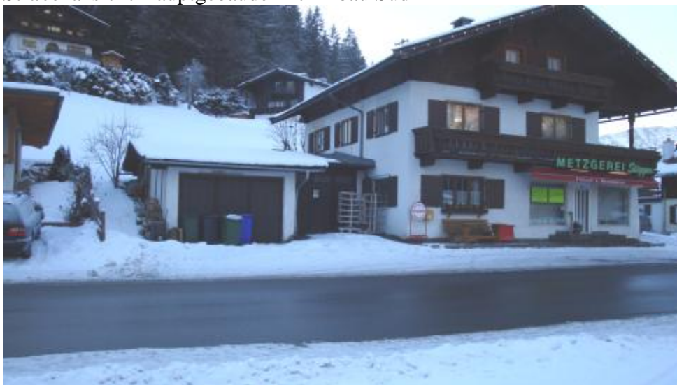
Straßenansicht Hauptgebäude mit Anbau Süd
