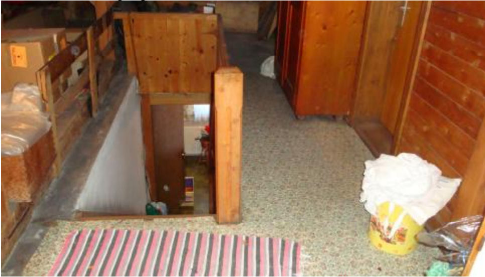
Dachraum mit Abgang 1.Stock
