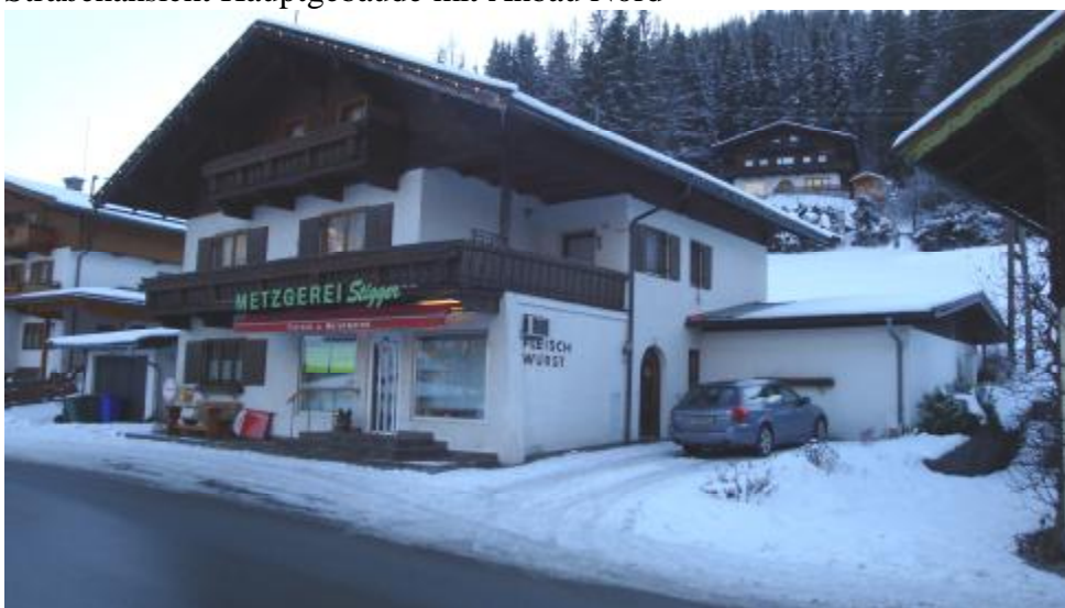
Straßenansicht Hauptgebäude mit Anbau Nord
